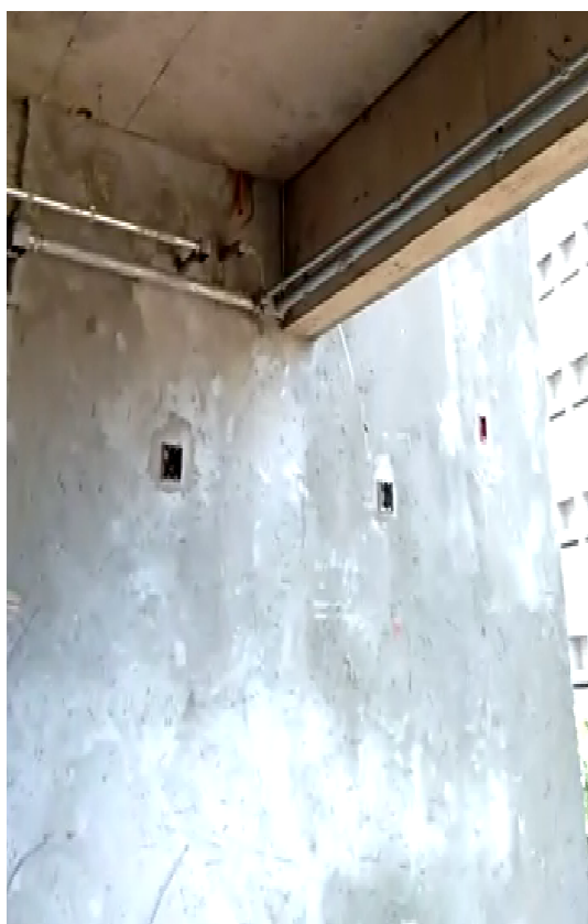
Caixas embutidas na alvenaria
